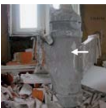
Cementno vezane grelne cevi
