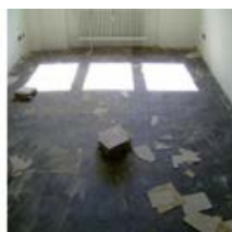
Plošče vinaz, linoleji z azbestnimi vlakni
